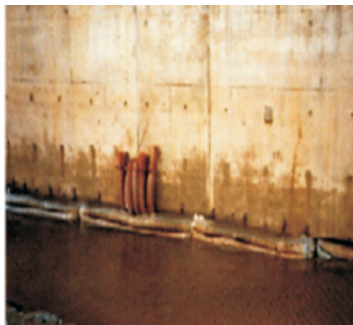
(d) Grout Bag Foundations
